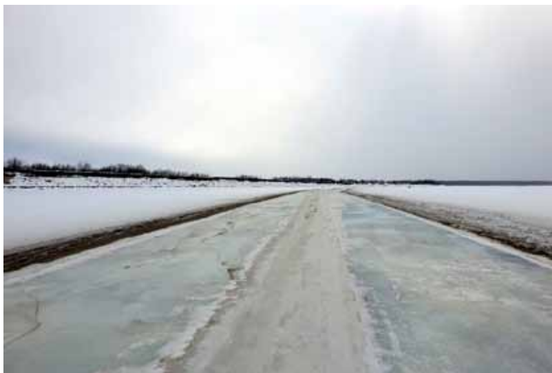
Рис. 2. Ледовая переправа через р. Лену в районе г. Якутска, март 2022 г. Фото автора.
